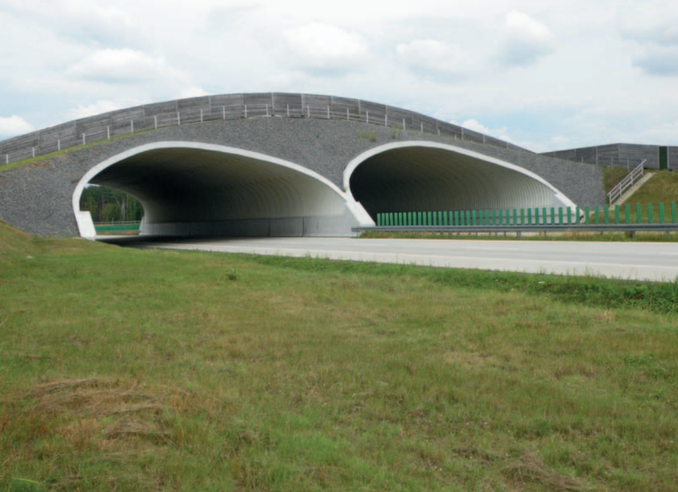
Fot. 29. Górne przejście dla zwierząt na autostradzie A4 w Borach Dolnośląskich. Pomimo stromych najsłabiej intensywnie wykorzystywane przez duże ssaki, w tym wilki (© R.W. Mysłajek)
