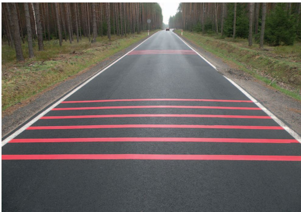
Fot. 28. Pasy akustyczno-wibracyjne na nawierzchni drogi przechodzącej przez Bory Dolnośląskie (© S. Nowak)
